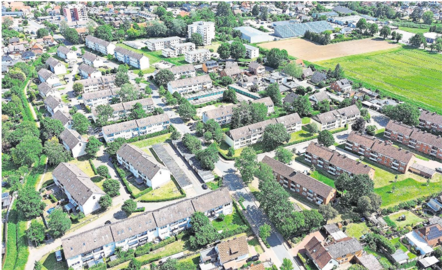
Die Nienburger Lehmwandlung bekommt ein Wärmenetz.
